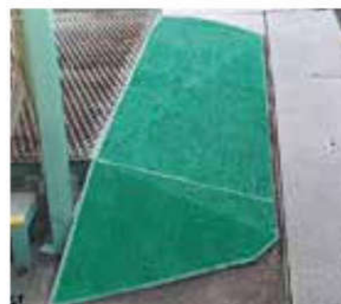
縞鋼板のスロープ
