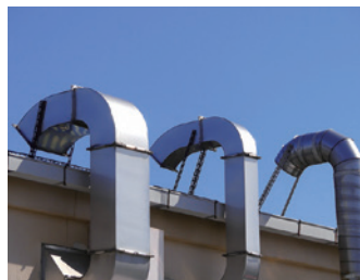
■ 工場のダクト・外装
