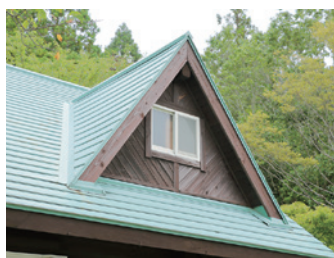
■ 屋根外装部（カラー鋼板、折板屋根等）
