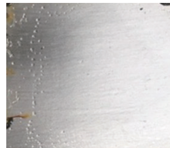
塗膜部分に錆は発生していません。
