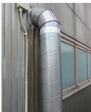
■ 工場外部の配管・ダクトの錆止め・保護
