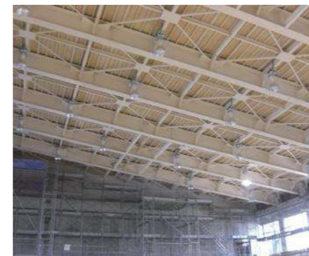
体育館 鉄骨梁
