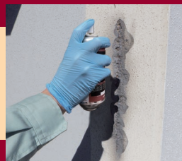
反応硬化させるため、逆さにして約10分間放置する。
