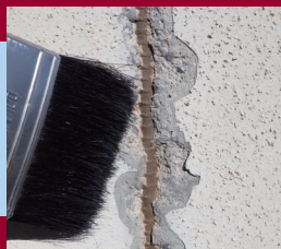
付着力のない浮きび、被塗部の塩分・油脂・塵埃・水分などを除去
